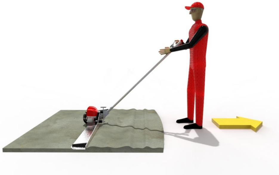
Abb. 8: Arbeiten beim Glätten und nachverdichten.
